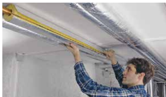
■ Instalação ULTIMATE PROTECT PIPE SECTIONS
