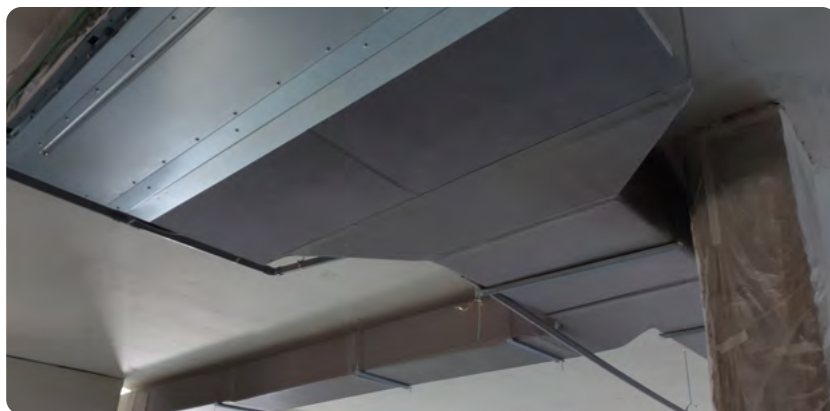
Ligação à máquina, instalação de condutas deco Climaver® A2.
