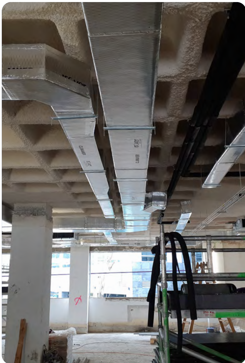
Instalação de condutas Climaver®. Reduções MTR.
