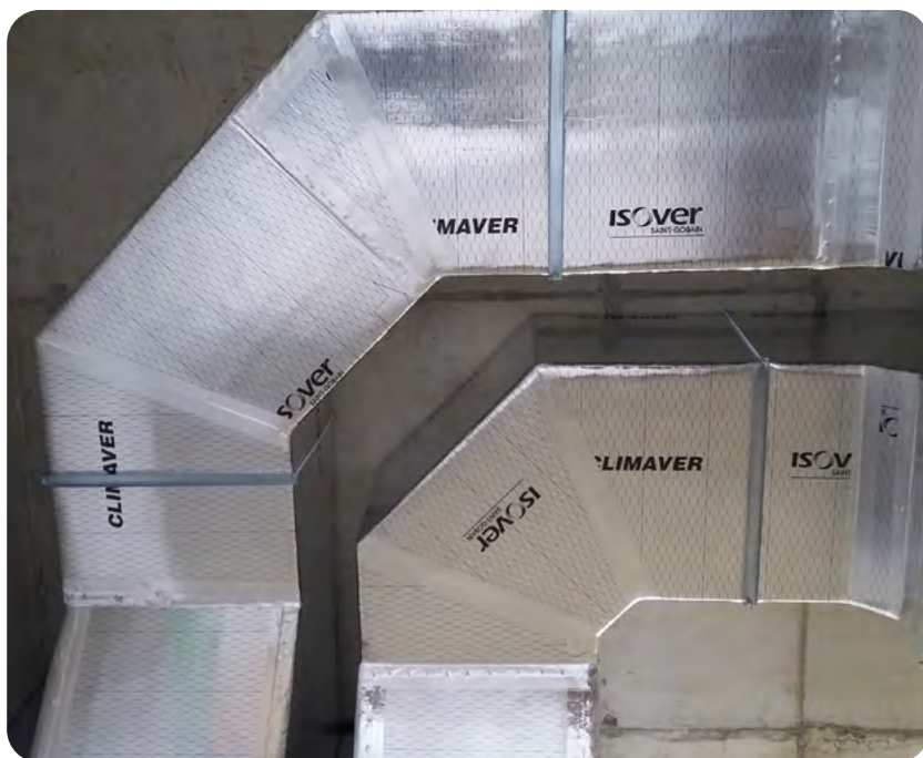
Instalação de condutas Climaver®.
