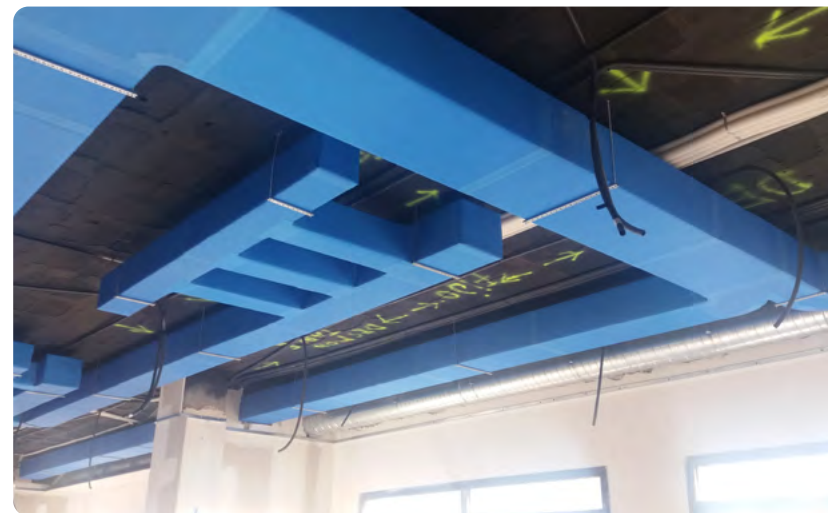
Suporte da instalação de ventilação Climaver® 360 A2 Deco.
