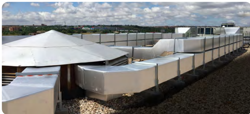
Instalação de condutas Climaver® 360 Star.
