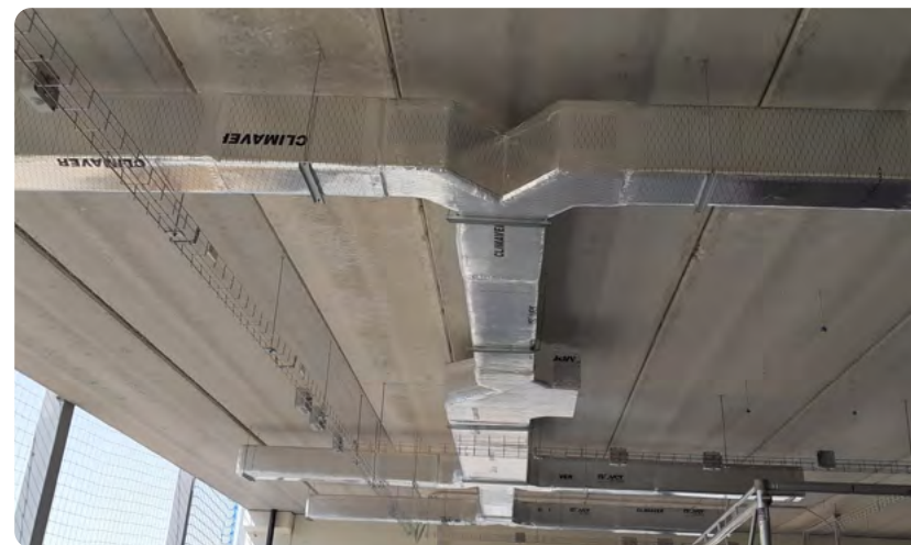
Instalação de condutas Climaver®.
