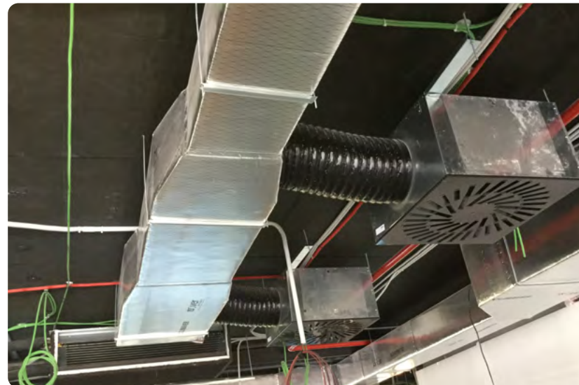
Instalação de condutas Climaver®. Ligação a difusor mediante conduta flexível.
