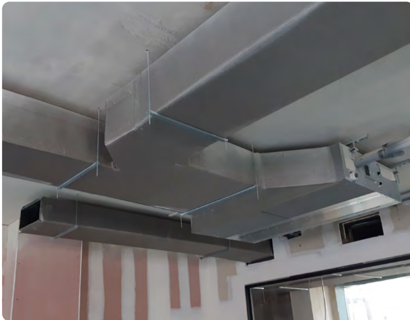
Instalação de condutas Climaver®. Inserção em máquina com redução de duas faces MTR.
