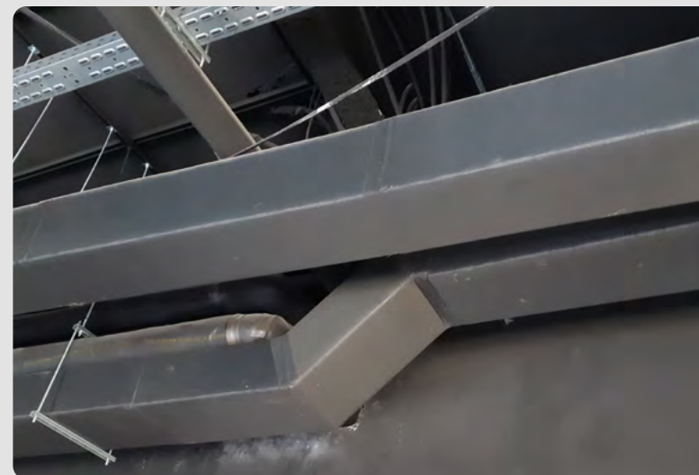
Instalação de condutas Climaver® 360 A2 Deco. Quebra MTR.
