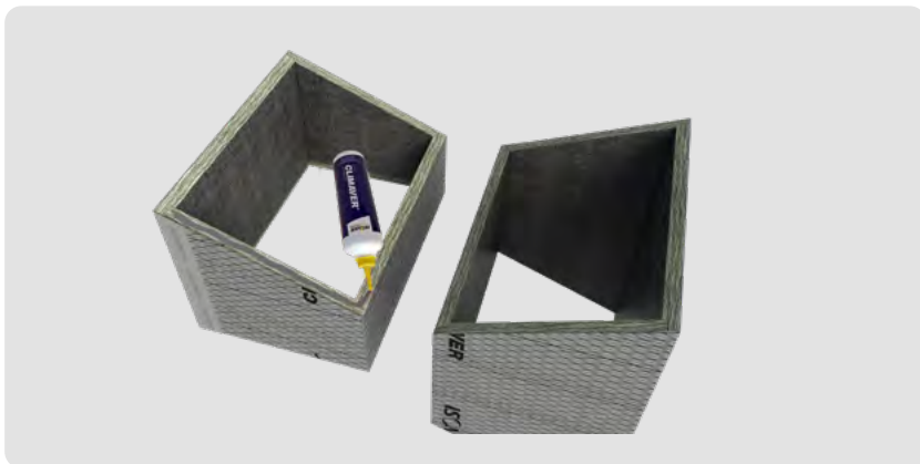
Selagem interior das figuras MTR com cola Climaver®.
