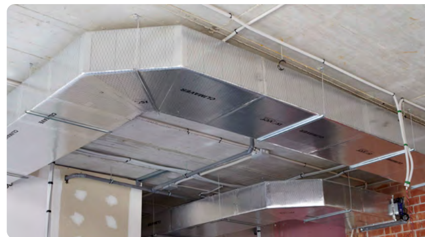
Instalação de condutas Climaver®. Cotovelo MTR.
