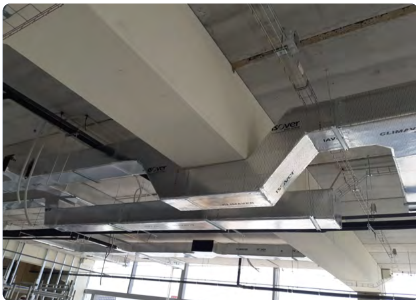
Instalação de condutas Climaver®. Contornar uma viga MTR.
