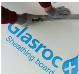
De corte similar a qualquer placa de gesso laminado comum, permite um **manuseamento facilitado e económico**.
