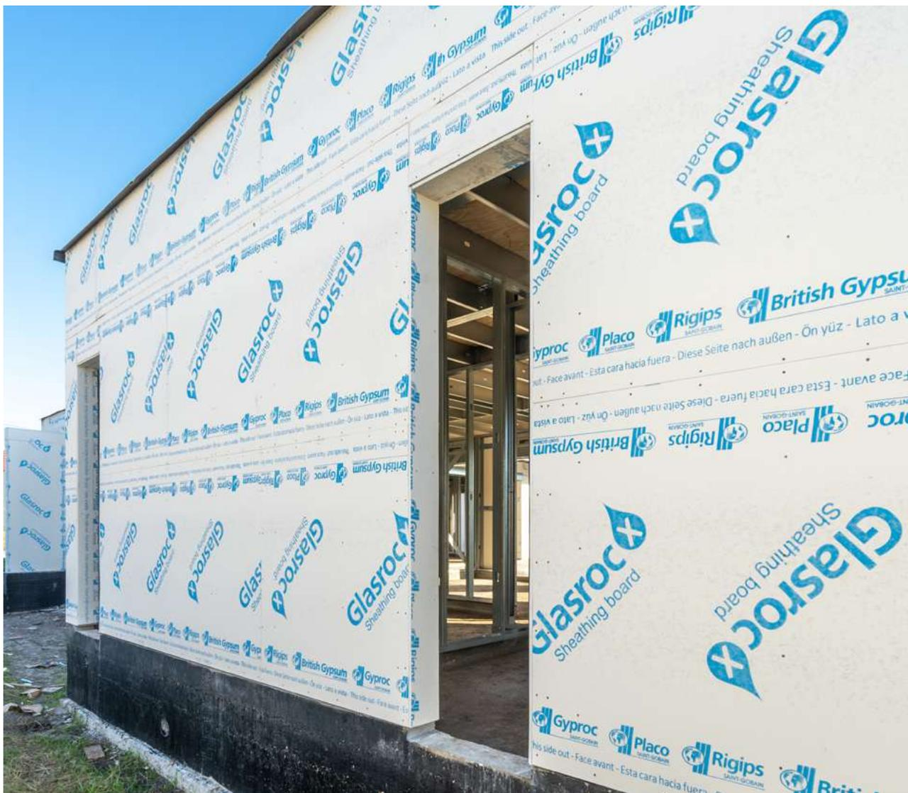
**Glasroc® X Load bearing** foi avaliada de acordo com os procedimentos de ensaios europeus standardizados e cumpre com todos os requisitos, de modo que com a **ETA21 / 0179**, passa a haver um documento de suporte para execução de construções com estrutura em madeira ou em LSF com utilização de **Glasroc® X Load bearing** na envolvente exterior vertical.
